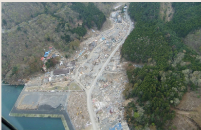
写真9 2011.5.1. 東日本大震災発生51日後の女川FC周辺。地盤沈下により港まで海水が浸入。小乗浜集落は壊滅してしまっった。 (木島明博撮影)
