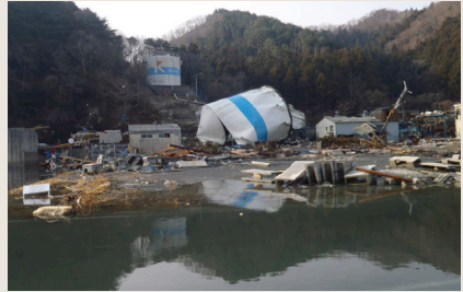
写真6 2011.3.12. 東日本大震災発生翌日の女川町沿岸。タンクが破壊され、転げ落ちてオイルが海に流出。 (女川FC 鈴木善幸氏撮影)
